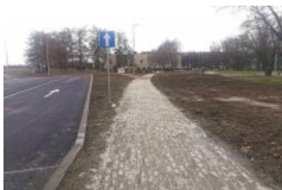
• Ulica Siemianowicka gotowa
