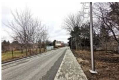
Ulica Siemianowicka gotowa
