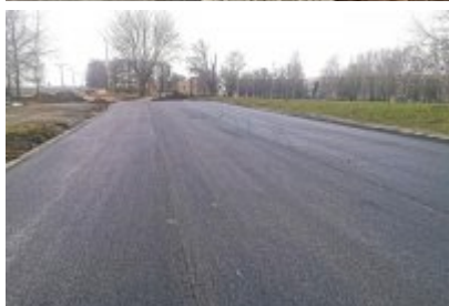
Ulica Siemianowicka gotowa
