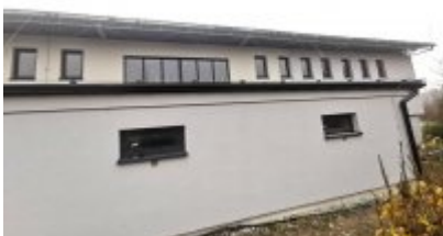
Remont trybuny stadionu
