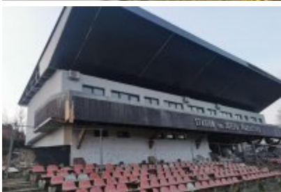
Remont trybuny stadionu
