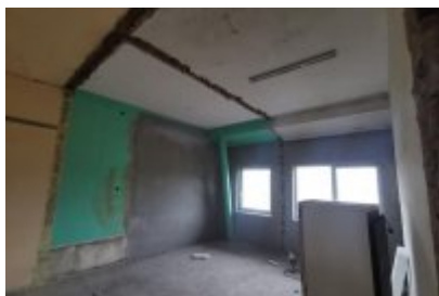
Remont trybuny stadionu
