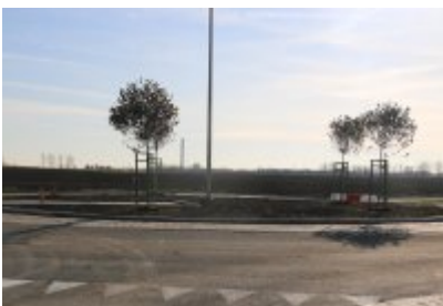
• Obwodnica osiedla Piłsudskiego w Czeladzi
