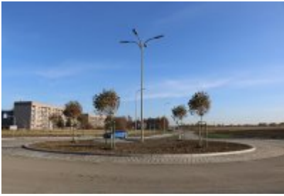
• Obwodnica osiedla Piłsudskiego w Czeladzi
