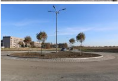
• Obwodnica osiedla Piłsudskiego w Czeladzi
