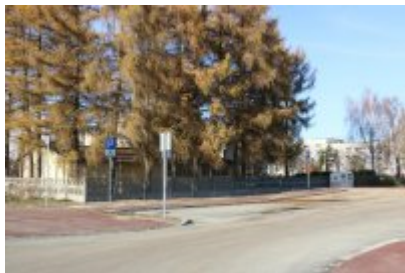
Obwodnica osiedla Piłsudskiego w Czeladzi
