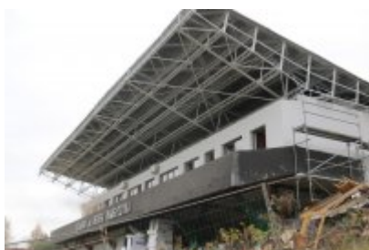
Hala sportowa po termomodernizacji
