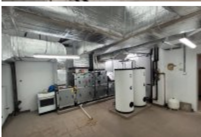
Hala sportowa po termomodernizacji
