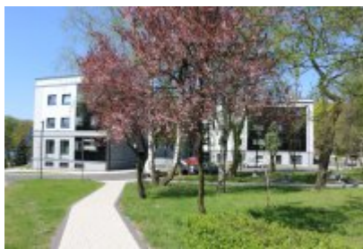
Termomodernizacja budynku Urzędu Miasta Czeladź
