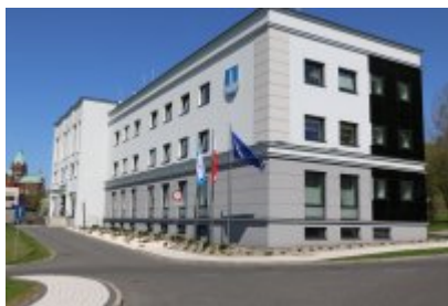
Termomodernizacja budynku Urzędu Miasta Czeladź
