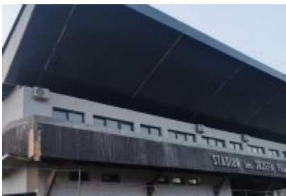
• Remont trybuny stadionu
