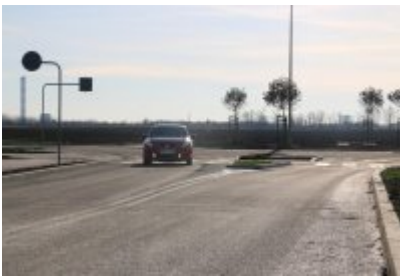
Obwodnica osiedla Piłsudskiego w Czeladzi
