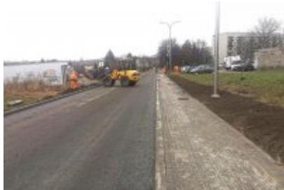
Ulica Siemianowicka gotowa
