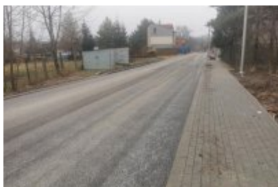
Ulica Siemianowicka gotowa
