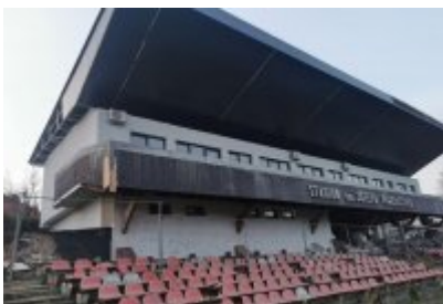
• Remont trybuny stadionu
