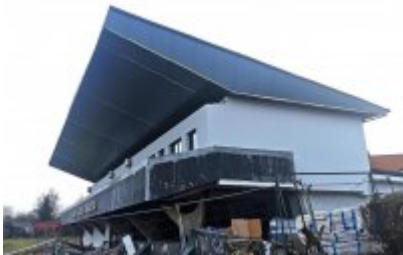
• Remont trybuny stadionu
