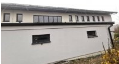
• Remont trybuny stadionu
