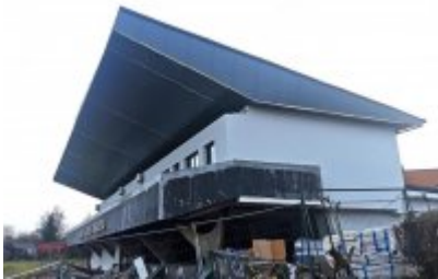
• Remont trybuny stadionu
