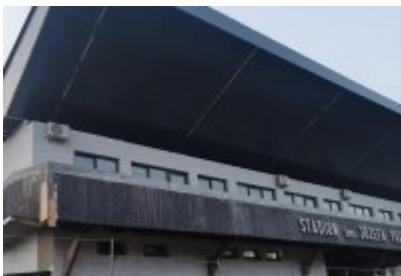
• Remont trybuny stadionu
